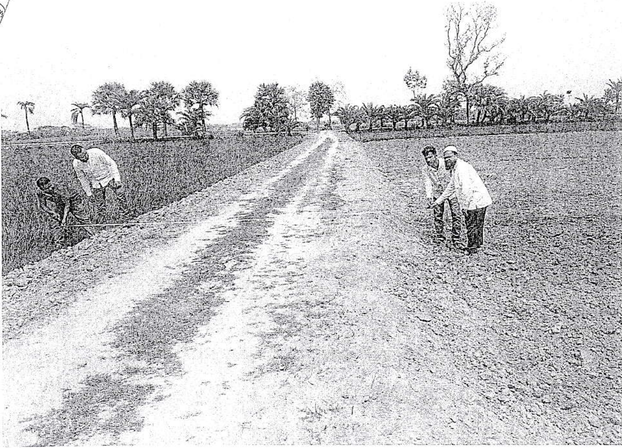
মানিকতলা হতে হেলাচি বাজার পর্যন্ত রাস্তা সংস্কার পরিদর্শন
